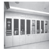
分電盤、制御盤
