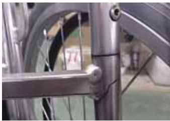
図52 フレームの亀裂
