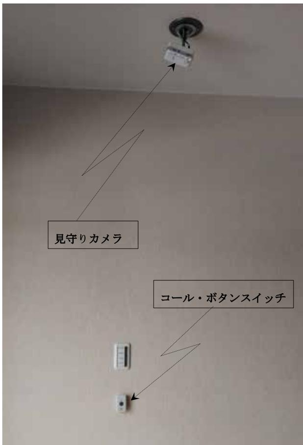
センサー類が変化を検知すると、スマートフォン、パソコンに写真付きのメールで通知を行います。または、ポップアップ表示で通知のみを行います。
