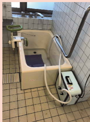
ピュアット設置の様子
