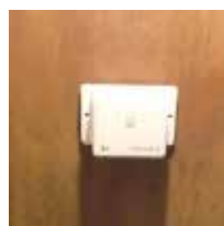
トイレ人感センサー ※天井設置
