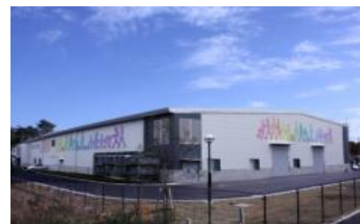
生活支援ロボット安全検証センター （茨城県つくば市）
