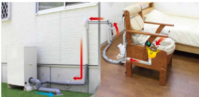
家具調トイレと真空ユニット(屋外仕様) (汚水を直接下水へ排水する)の組合せ
