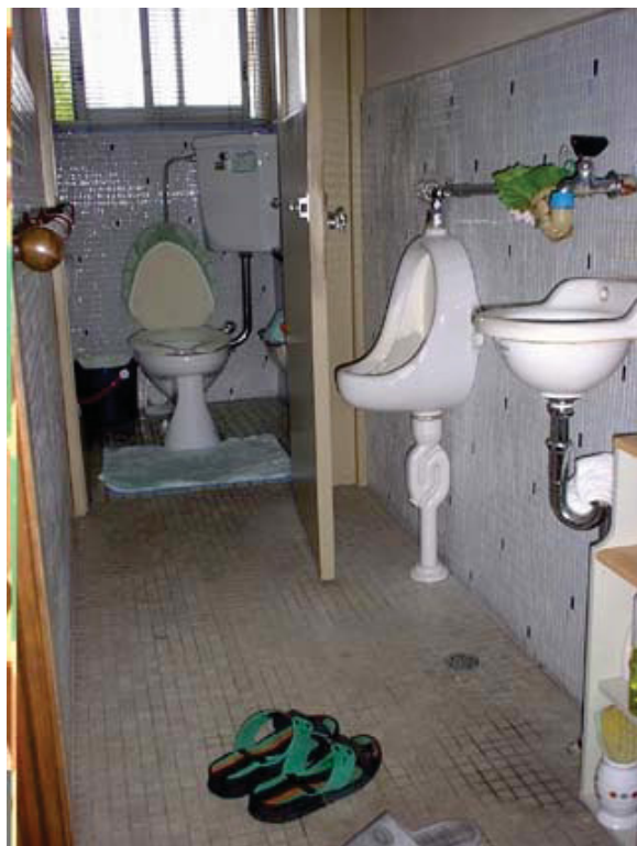
改修前のトイレ
