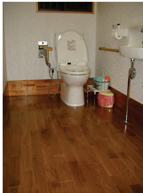
間口を広く改修
