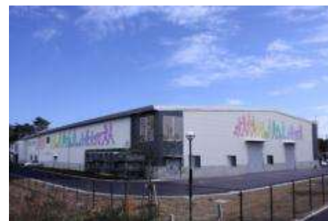
生活支援ロボット安全検証センター (茨城県つくば市)
