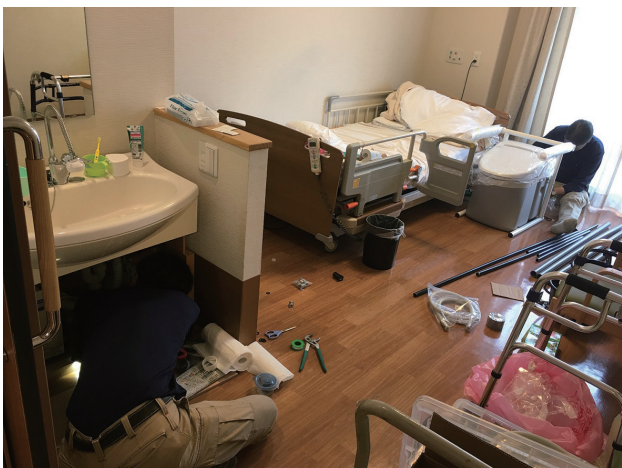
設置工事の様子
