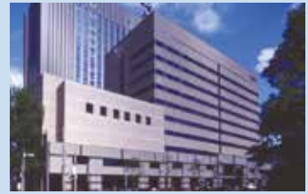
北海道介護実習・普及センター （かでの2・7）外観
