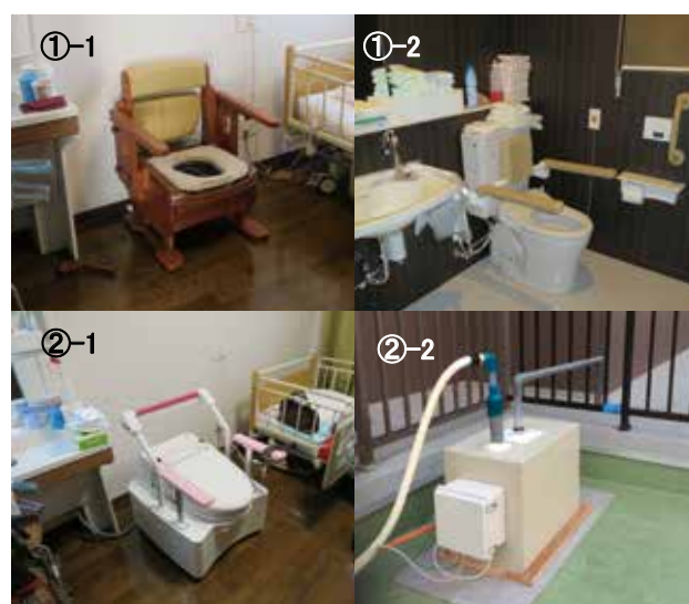
図2 使用トイレ (①-1ポータブルトイレ、①-2共用トイレ、②-1wellsトイレ、②-2wellsトイレポンプ)
