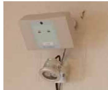
機器設置の様子
