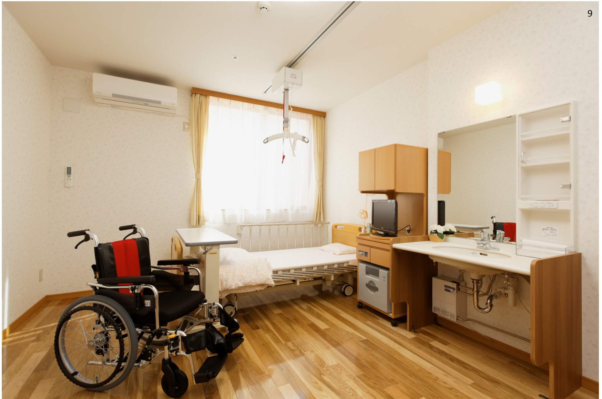
天井走行リフト（居室内）
