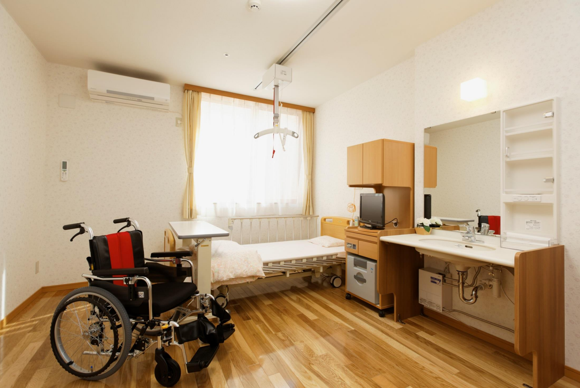
天井走行リフト(居室内)
