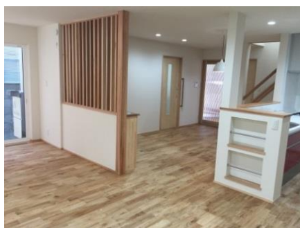
改修後の内部、クリのフローリング 窓はすべて樹脂窓を採用
