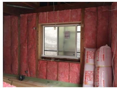
壁の断熱、屋根も同様に断熱を実施、生活動線に合わせたゾーン基
